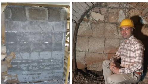
دمپر بتنی چپ (پس از ساخت) راست: پس از شش ماه سرویس دهی
