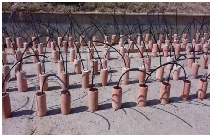
استفاده از رزین در بخش فوقانی سفال ها برای آبنبدی و استحکام
